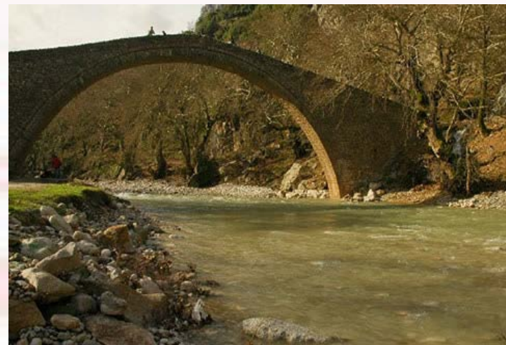
Γέφυρα Άγιου Βησσαρίωνα Πύλη Τρικάλων
