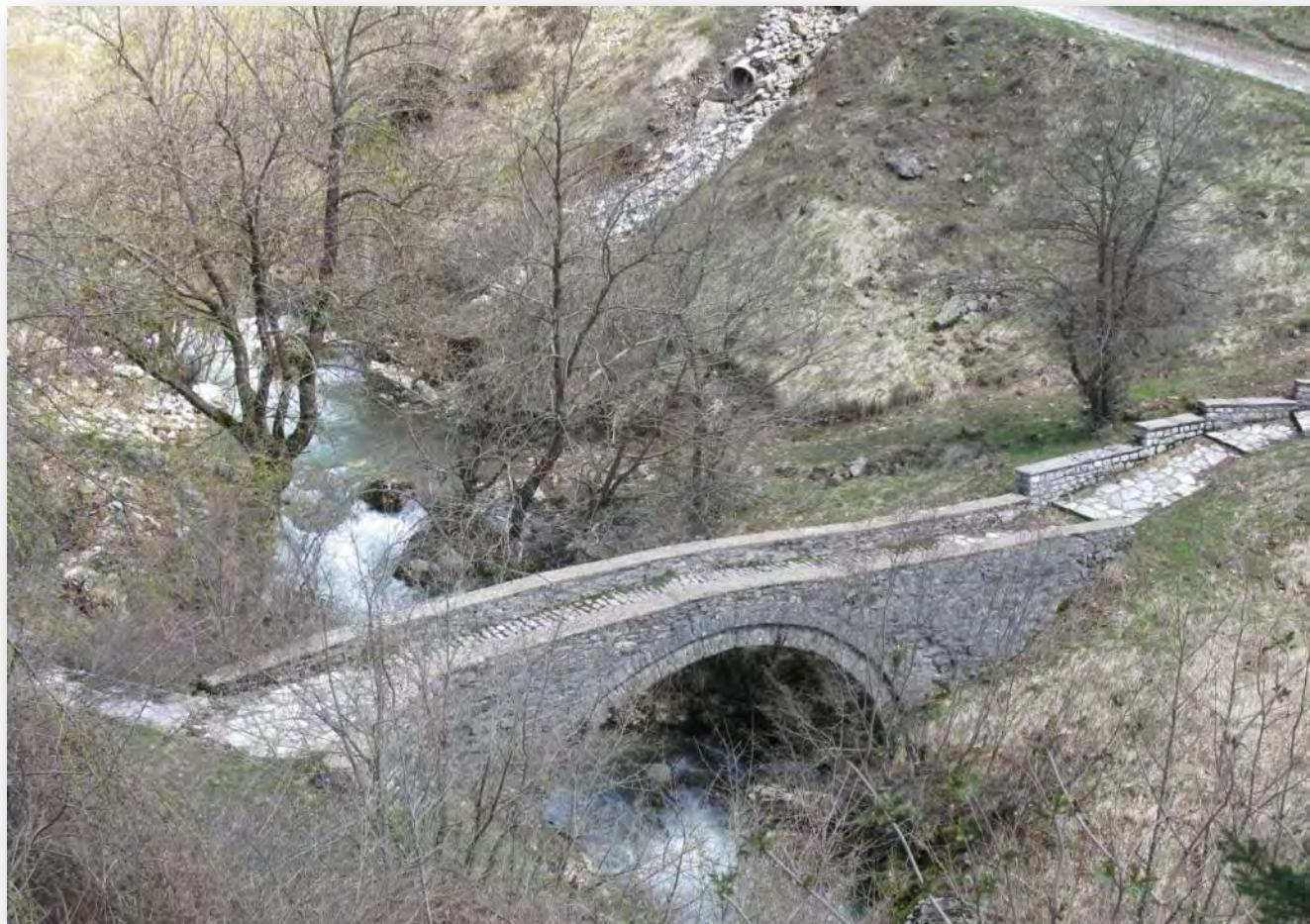
Μονότοξο ημικυκλικό γεφύρι χτισμένο πάνω σε βράχο. Κατασκευασμένο τον 18ο αιώνα, επισκευάστηκε το 1980. Εξωτερικά από πελεκητές ασβεστολιθικές πέτρες, εσωτερικά ακανόνιστες. Το ύψος του είναι 4,3μ, το μήκος του 5,8μ, ενώ το συνολικό του ανάπτυγμα είναι 16,5μ.
