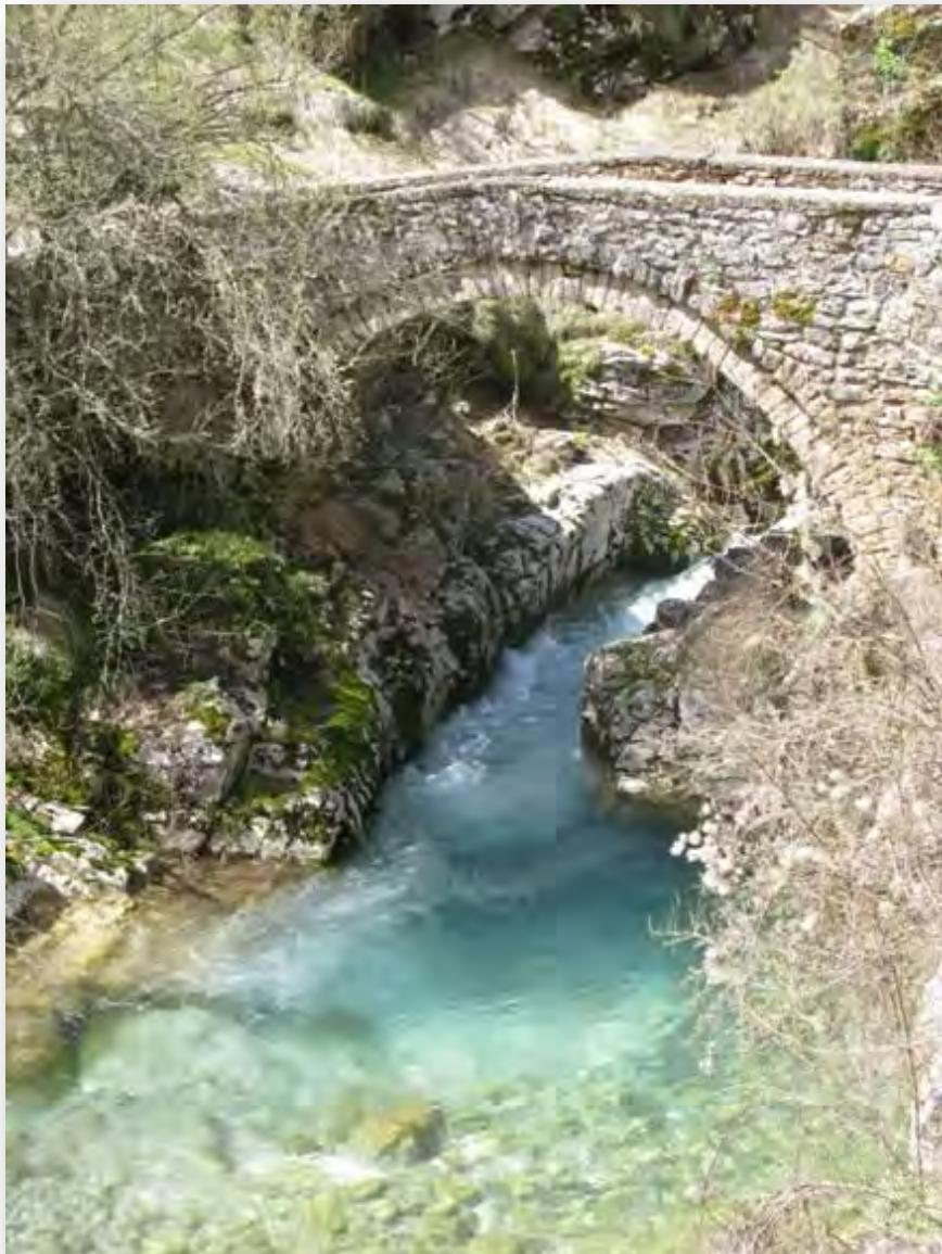
Μονότοξο ημικυκλικό γεφύρι θεμελιωμένο πάνω σε βράχο. Κατασκευασμένο τον 18ο αιώνα, επισκευάστηκε το 1991. Εξωτερικά από ασβεστολιθικές πελεκητές πέτρες, εσωτερικά ακανόνιστες. Το ύψος του είναι 6,1μ, το πλάτος του φορέα από 1,45μ έως 2,25μ, με άνοιγμα του τόξου 7,2μ.
